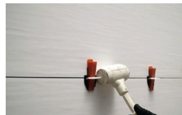
13. Trascorso il tempo di asciugatura si procede alla rimozione degli autolivellanti, orientando il martello come indicato. 13. Once the drying time is over, the self-levelling spacers are removed by placing the hammer as indicated. 13. Au terme du séchage, enlever les entretoises autonivelantes en orientant le marteau comme illustré. 13. Nach dem Trocknen werden die selbstnivellierenden Zuglaschen und Abstandhalter entfernt, dabei den Hammer wie im Bild gezeigt ausrichten. 13. По истечении времени система выравнивания плитки удаляется.
